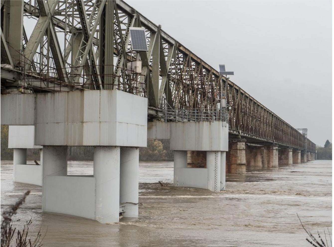
Tra il 6 e 7 giugno 2011 vengono eseguiti dei rilievi sul letto del fiume, per determinare la profondità della buca che ha causato il cedimento e il crollo del pilone 9.
